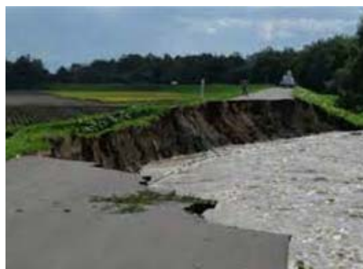
図-1 左：堤防決壊 右：河岸侵食
