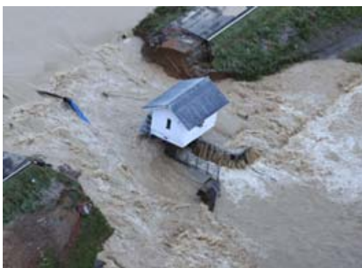
図-1 左：堤防決壊 右：河岸侵食
